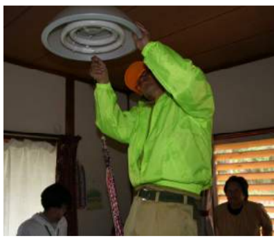
古い蛍光灯を交換
